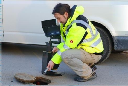
optische Kamerainspektion in Trinkwasserleitungen
